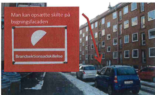
Det er en mulighed (men ikke et krav) at opsætte skiltning på bygningsfacaden, så brandkams-erstatninger er lette at identificere for redningsberedskabet under en brand.
